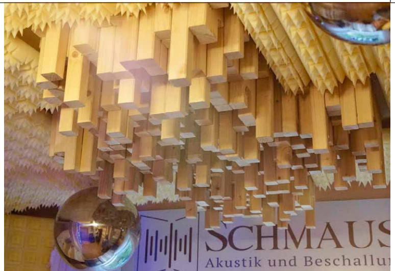
Mit einer Säge und viel Geduld hat der Firmeninhaber auch diese Decken-Diffusoren selbst gefertigt
